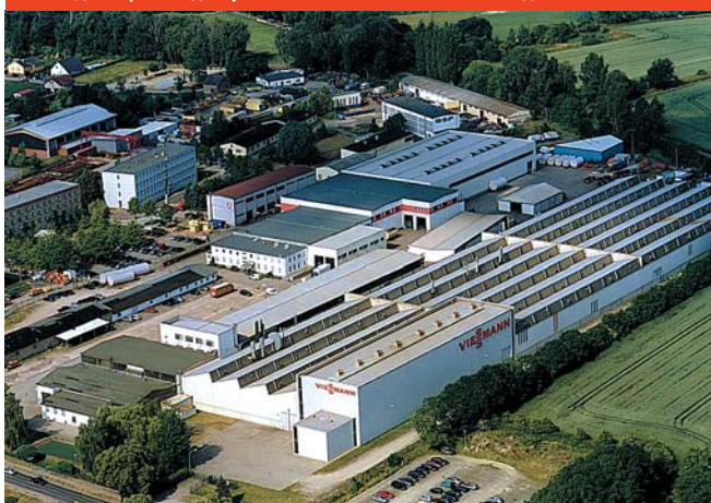
Завод по производству котлов Vitomax в г. Миттенвальде
