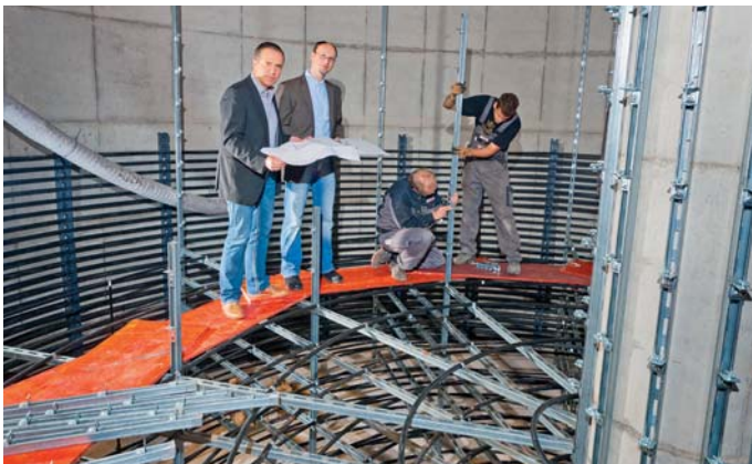
Verlegen der ringförmigen Wärme- tauscher im Eis-Energiespeicher. Der Durchmesser beträgt 10 Meter, die Höhe 6 Meter.
