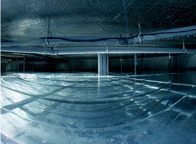
Die Kristallisationsprozesse im Eisspeicher können per Kameraübertragung visualisiert werden.
