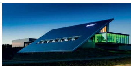
Maximale Energieausbeute mit dem nach Süden ausgerichteten Pultdach.
