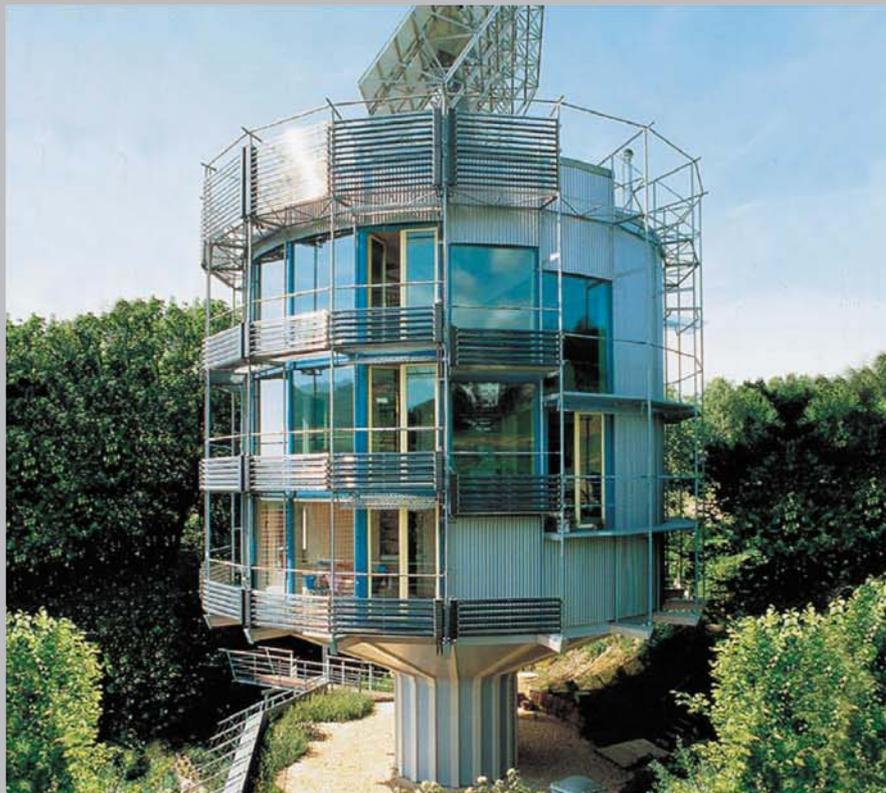
Рис. 51. Здание «Гелиотроп», Фрайбург, с коллекторами из вакуумных трубок
