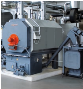
Твердопаливний котел Vitoflex 300-RF з ротаційним спалюванням пелет, крупної та дрібної деревної тріски
